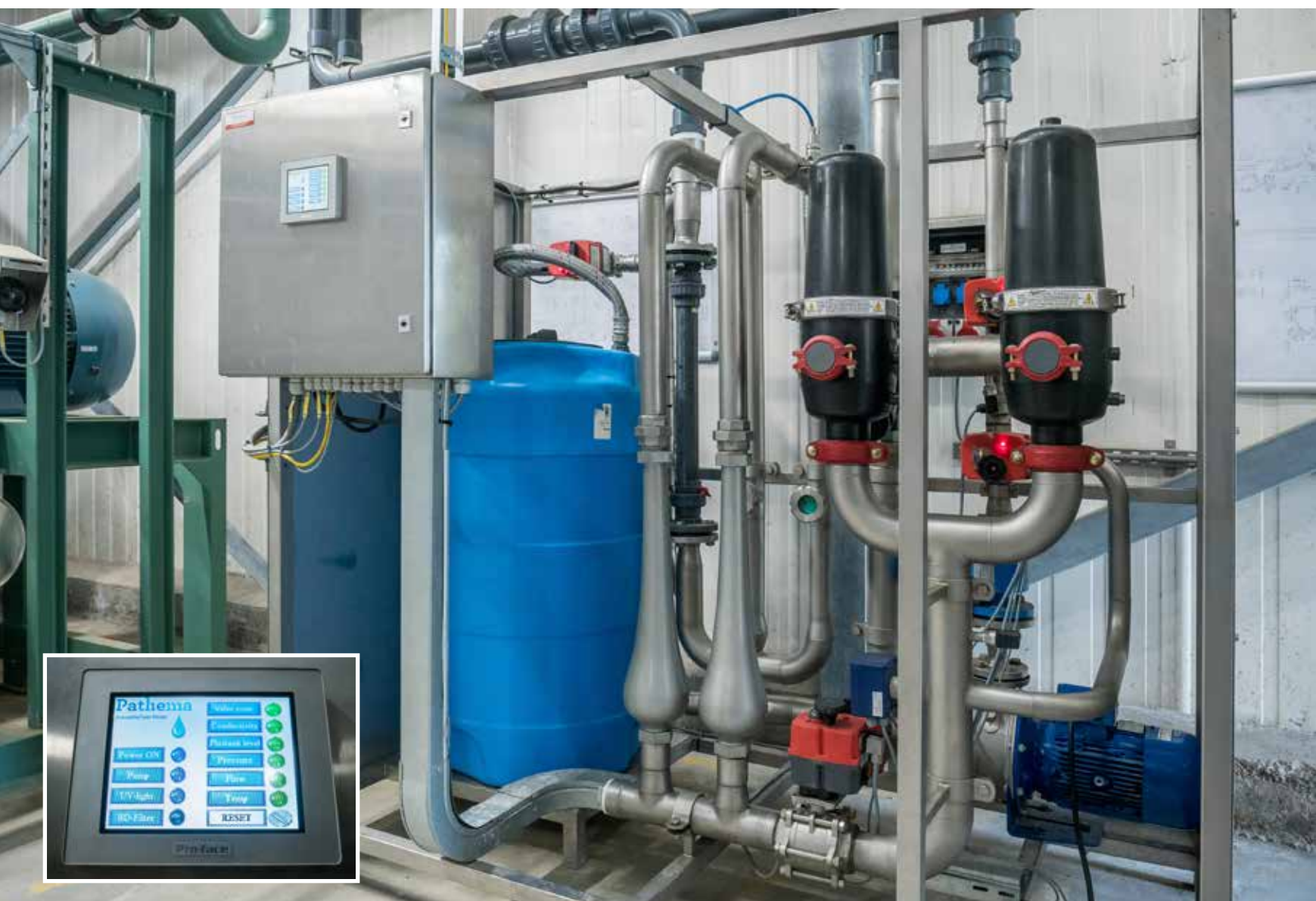
De IVG-C werkt met een kristallisatietechniek die voorkomt dat kalk zich op de warmtewisselaar afzet.
